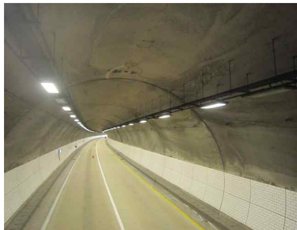
[하행선 내부 전경]
